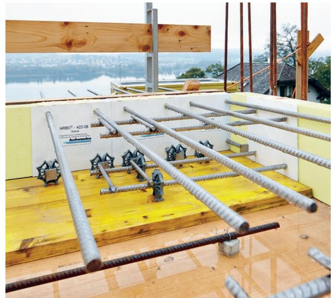
Le module de calcul ARBO/CRET est un programme d'éléments finis qui calcule les armatures de raccordement de dalles en porte-à-faux ARBO et les goujons pour la transmission de charges transversales CRET en tenant compte de toutes les actions. Le logiciel 3D d'Ingware (Axis VM) adapté aux produits Aschwanden vous permet de définir la position et la charge exactes des armatures de liaison et des goujons. Cela permet une disposition optimale et économique des éléments ARBO et CRET.
