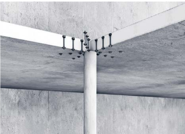
RINO Bar: Anordnung im Querschnitt
