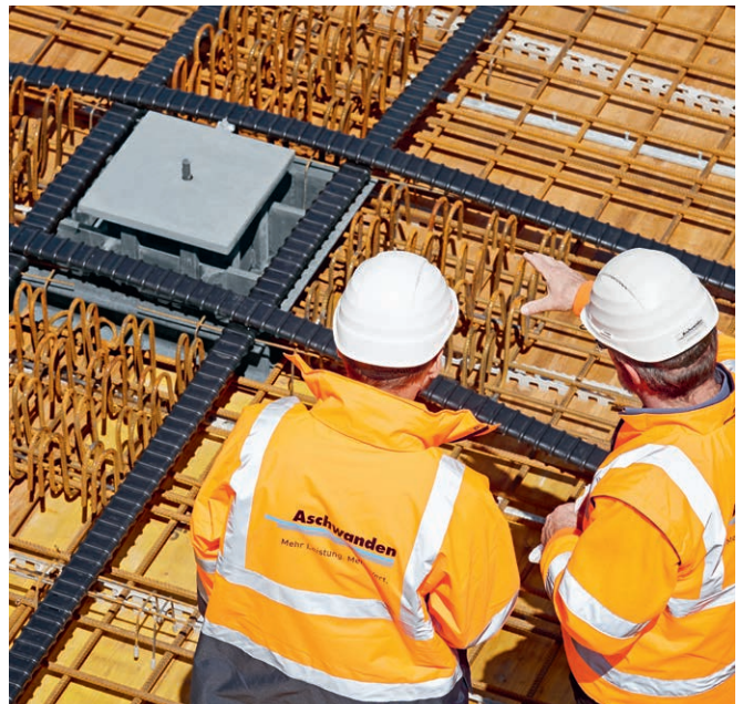
Les têtes en acier DURA sont associées aux paniers d'étriers DURA et adaptées au positionnement des éléments précontraints.
