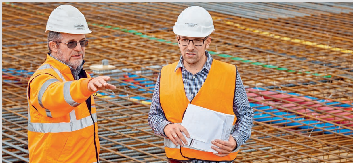
Avec Konrad Rohner de chez Aschwanden, Patrick Roos (à dr.) discute des travaux de montage.
