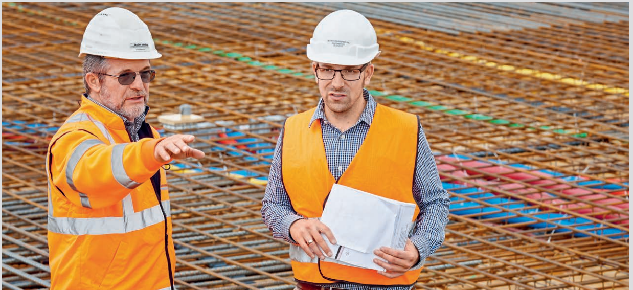
Gemeinsam mit Konrad Rohner von Aschwanden bespricht Patrick Roos (rechts) die Montagearbeiten.
