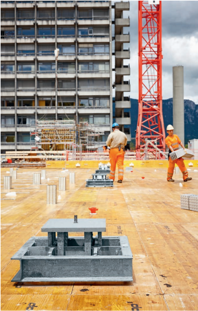
Rund 500 Stahlpilze in verschiedenen Ausführungen werden beim neuen Bürgerspital eingebaut.
