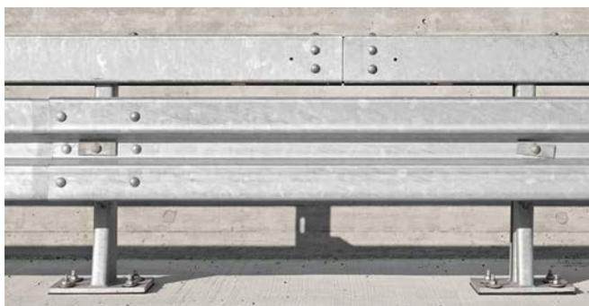
Les ancrages RIBA visent toujours la sécurité, indépendamment du fait qu'il s'agisse de la fixation de glissières de sécurité et de mains courantes ou de transmission de forces entre éléments structuraux. Il est donc tout à fait logique que l'ancrage lui-même soit absolument sûr.
