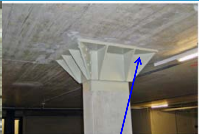
Verstärkung der Durchstanzung mit Stahlton-Köpfen + Ancosan
