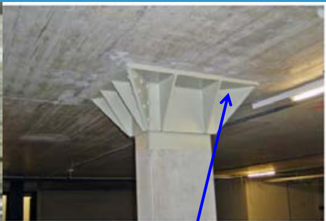
Verstärkung der Durchstanzung mit Stahlton-Köpfen + Ancosan
