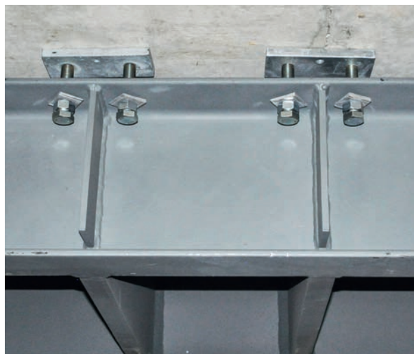
Zwei Verfahren zur Vorspannung des Stahlpilzes : mittels verlorener Presse zwischen Stützkopf und Pilz (li.) oder mit Schrauben entlang des Randträgers (re.). Seltener sind die ergänzten Pilzabstützungen am Stützenfuss, die aufgedrückt werden.
