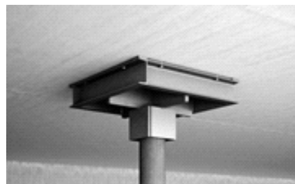
Bild 50: Durchstanzverstärkungssysteme a) nachträglich installierte Durchstanzbewehrung und b) nachträglich installierte Stützenkopfvergrößerung
