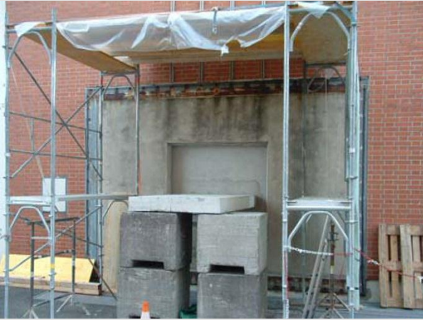
Bild 7: Ansicht der EMPA-Versuchsanordnung ohne Nutzlast (Quelle: EMPA Untersuchungsbericht Nr. 446465)
