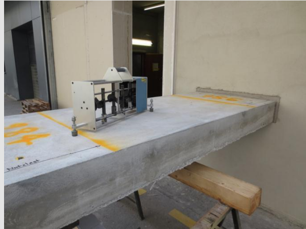
Bild 8: Einbau der Podestplatte ohne Nutzlast am Fraunhofer Institut IBP
