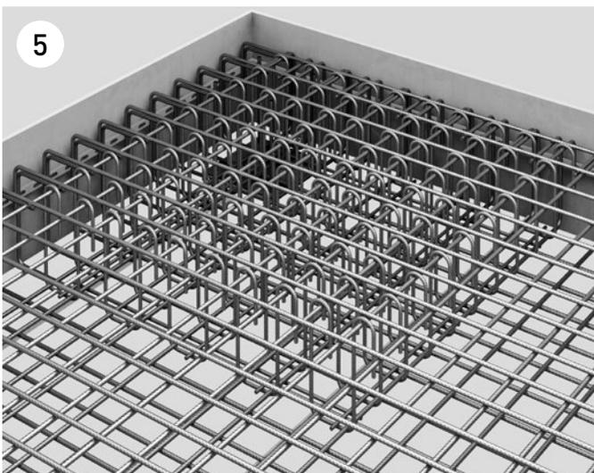
Die zweite Lage der oberen Bewehrung (4. Lage) wird verlegt. Le deuxième lit de l'armature supérieure (4<sup>e</sup> lit) est posé.
