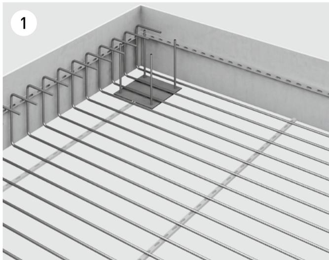
Die erste Bewehrungslage wird verlegt.
