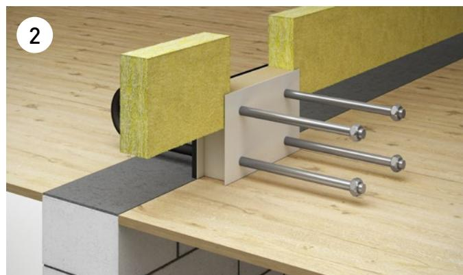
Seitlich Isolationsmaterial Steinwolle max. 100 kg/m<sup>3</sup> anschliessen.
