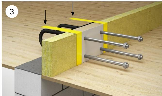
Abkleben der Füllmaterial-Fugen gegen die erste und zweite Betonieretappe.
