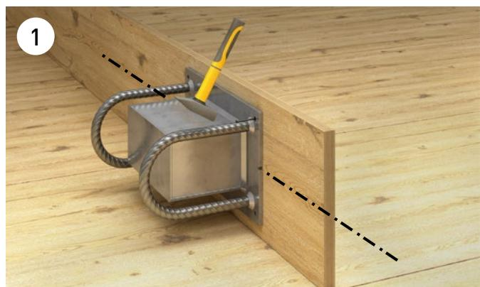
Höhenversatz zur Dornachse einmessen. Hülse auf Schalung nageln. Bauteil betonieren.
