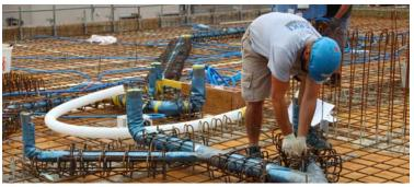
DURA Box: une solution simple, rapide et économique pour des armatures d'effort tranchant pour conduites dans des planchers-dalle.
