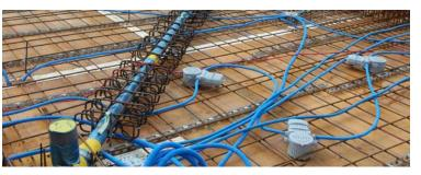
Les paniers d'armature de la DURA Box sont non seulement posés facilement et rapidement, mais ils suivent également le cheminement des conduites et peuvent être posés à des angles ou des rayons de courbure quelconques.
