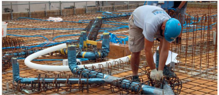
DURA Box: eine einfache, sichere und wirtschaftliche Lösung für Querkraftbewehrungen bei Leitungen in Flachdecken.
